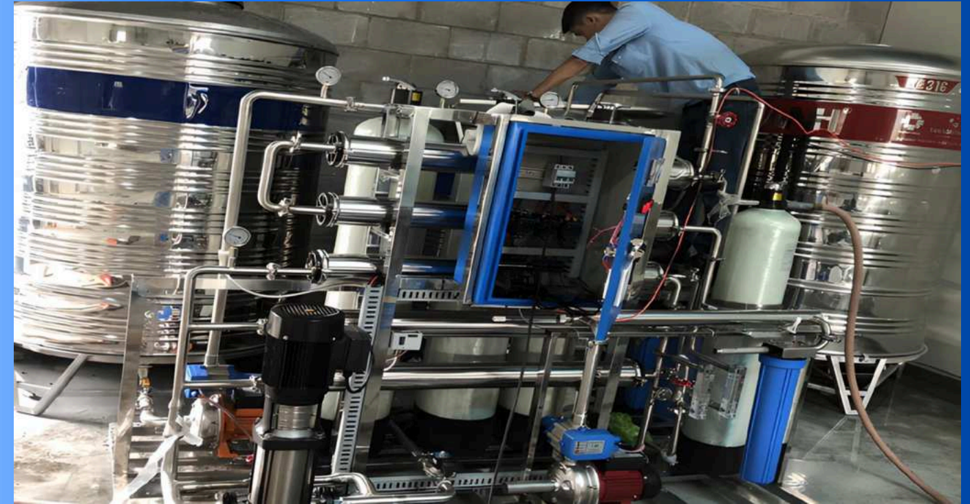
HỆ THỐNG LỌC NƯỚC SIÊU TINH KHIẾT RO-DI SẢN XUẤT MỸ PHẨM
