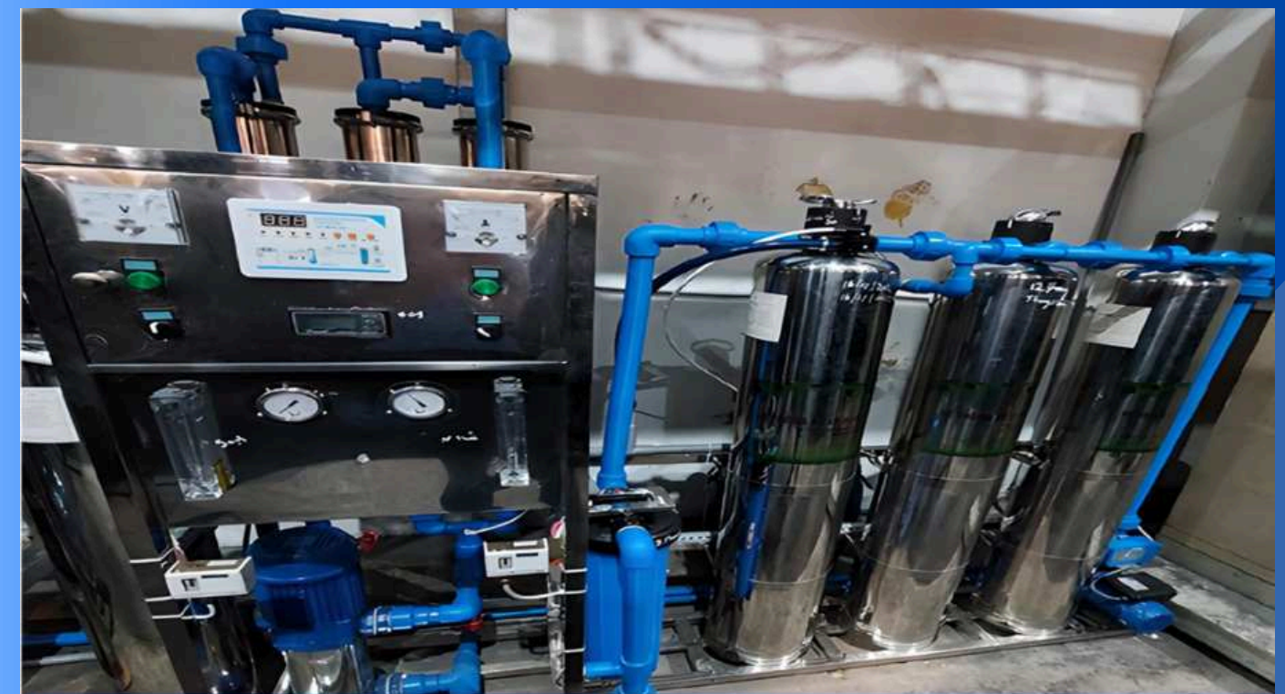
HỆ THỐNG LỌC NƯỚC SIÊU TINH KHIẾT RO-EDI SẢN XUẤT XI MẠ
