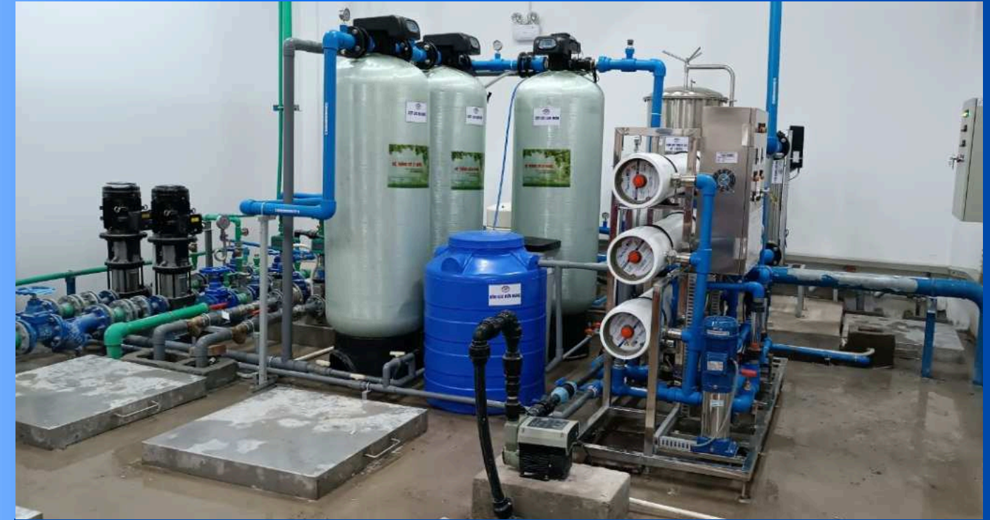
HỆ THỐNG LỌC NƯỚC RO 60M3 NGÀY ĐÊM
